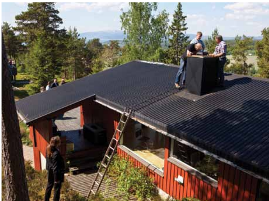
PIPESTUDIER: Hva slags type pipe det var på huset hadde mye å si for behovet for branntekniske utbedringer. Advokat Stine Hjøllum fra Protector følger spent mens de to meddommerne Magnus Kolstad og Atle Romstad, samt sakkyndige Reidar Nordstrøm, studerer pipen.
